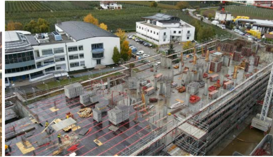
OPERE STRUTTURALI AL GREZZO ROHBAUARBEITEN
